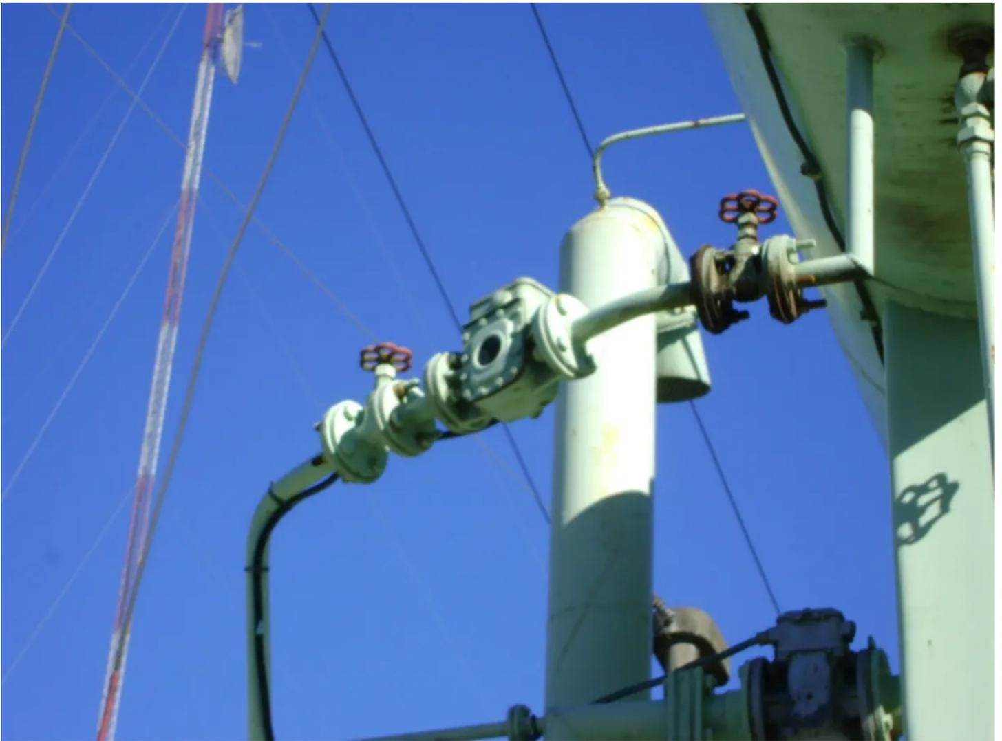
Los gases que pueden producirse en el interior de la cuba suben por el caño en el cual está instalado el relé Buchholz (esquema 1) quedando atrapado en este.
